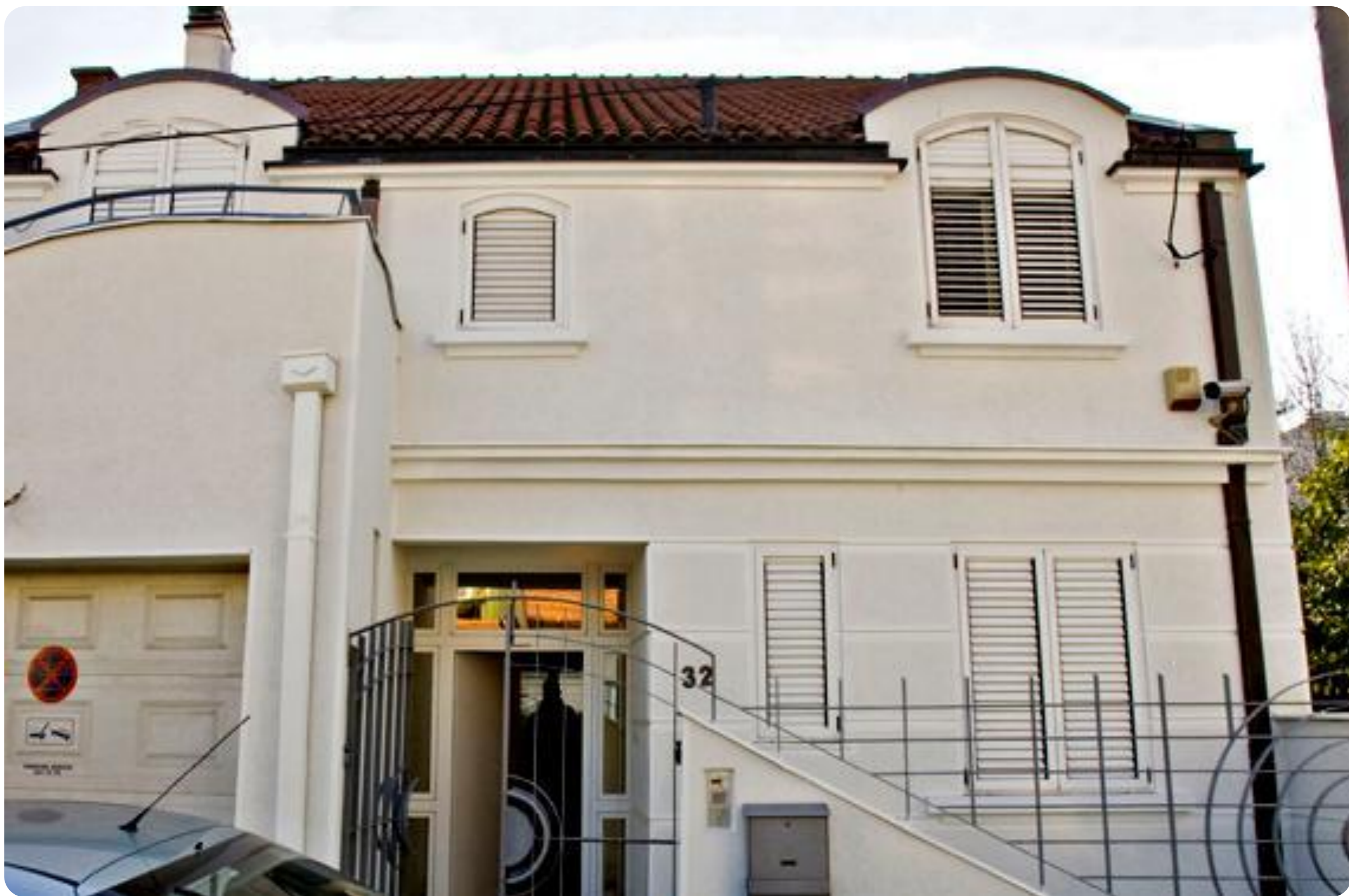
Roditeljska kuća Vračar, Beograd
